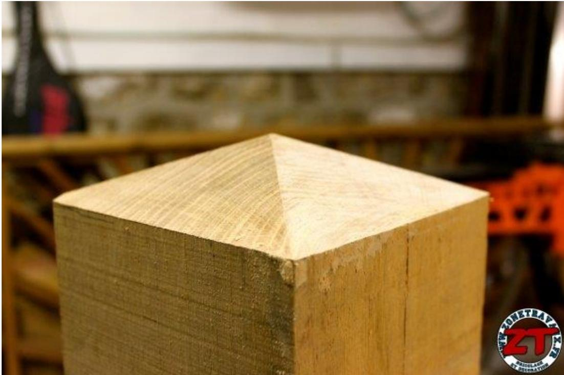
Ensuite, je réalise exactement la même préparation sur le bas du poteau que pour ceux de la pergola ([détails ici](#)). Les emplacements des boulons tête ronde ont été préparés à l'aide d'une mèche à tête plate de 20. Petit contrôle de profondeur à l'aide de mon pied à coulisse.
