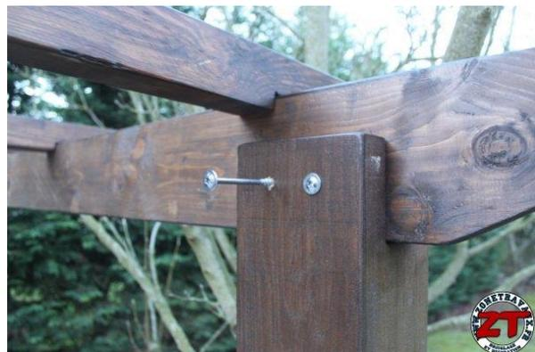
A ce stade, la panne est solidement vissée aux 2 poteaux. Il me reste maintenant à fixer les chevrons sur les 2 pannes. J'utilise la même méthode pour choisir le type vis à utiliser. Mes chevrons font 63 mm d'épaisseur, mes vis devront donc avoir une partie sans filetage d'au moins 63 mm.
