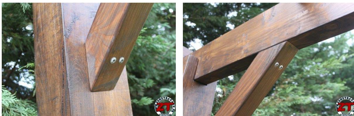
Le renfort est maintenant en place et solidement vient solidement arrimer la structure. J'avoue être vraiment satisfaite de ces finitions car tout s'ajuste parfaitement !
