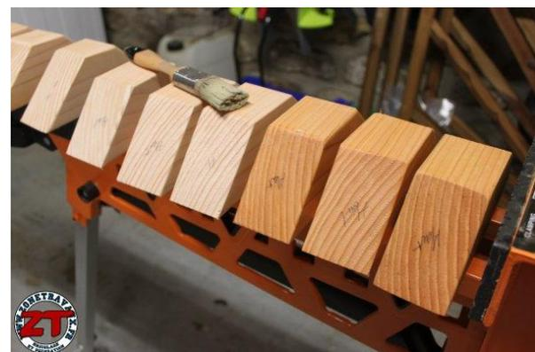
N'oubliez pas qu'aux endroits des découpes ou sur les zones d'assemblages, il faut bien insister pour que le produit pénètre bien le bois, exemple sur les poteaux.
