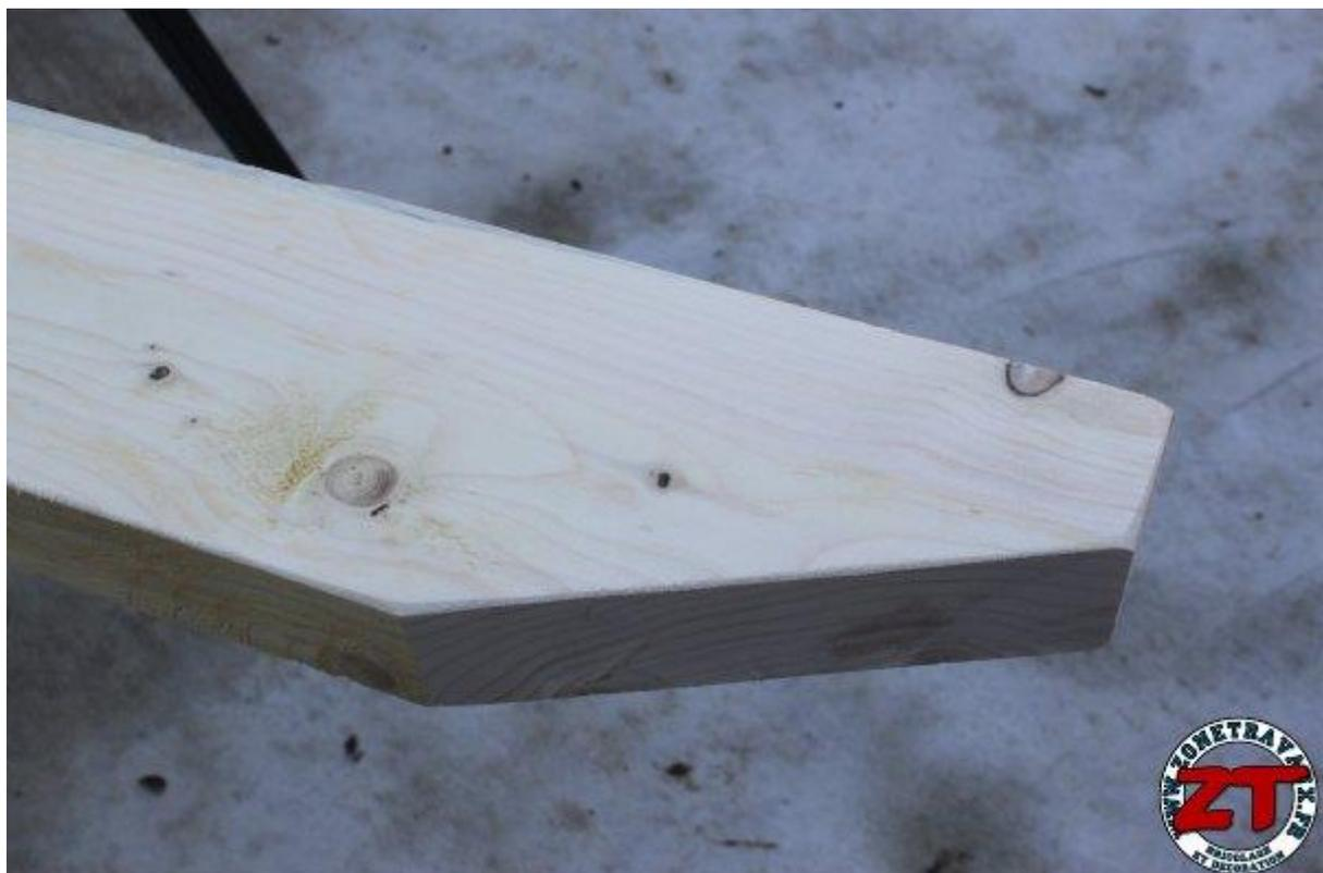
Pour la panne qui est scellée au mur, j'ai réalisé 6 trous à l'aide d'une mèche à bois plate de 20. Ces trous accueilleront les tiges filetées du mur. L'autre panne n'a besoin de rien d'autres que les découpes et le ponçage.
