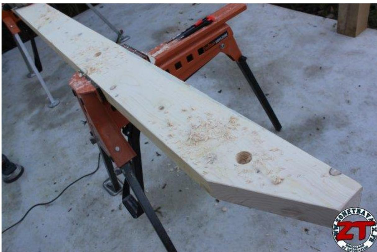
Enfin, après avoir réalisé les 6 trous nécessaires à la fixation du bastaing, je le positionne sur le mur en alignant les tiges filetées avec les trous du bastaing. Avec un peu de chance, cela tombera parfaitement en face des trous et vous n'aurez aucun reperçage à faire !
