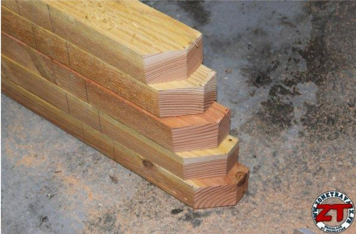
Puis je réalise l'encoche en faisant attention de bien respecter mon angle de 3°. 2 coupes à l'aide de la scie à onglet et je retirerais le reste avec un couteau à bois.
