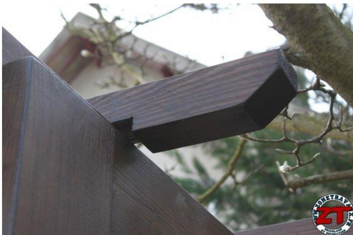
Si tout se passe bien et que vos mesures étaient correctes, les poteaux devraient être parfaitement perpendiculaires au sol et les encoches situées sur les chevrons devraient se situer au dessus de la panne. La pergola commence à prendre forme et nous pourrons passer à la fixation définitive des éléments à l'aide de la visserie adéquate.
