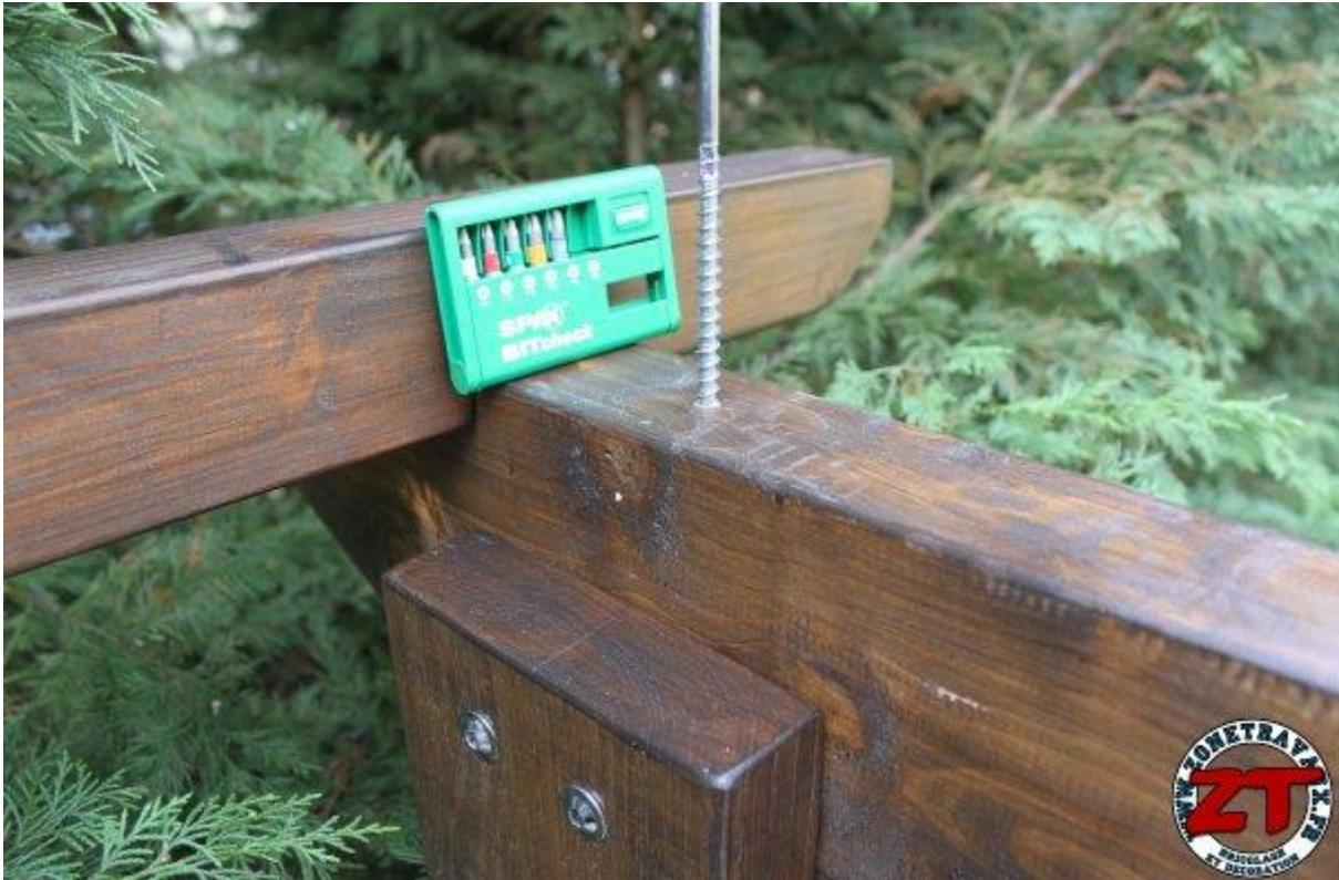
Pour finir le serrage de la panne sur les poteaux, je fixe des vis en travers sur le même principe. J'aurais pu aussi utiliser des tire-fonds pour fixer la panne à ce niveau.
