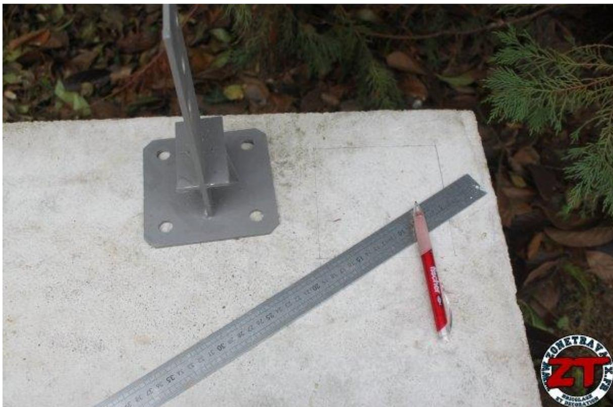
Pour le perçage d'une dalle en béton brute, j'ai utilisé ma perceuse AEG filaire (il faut du costaud) en mode percussion et mèche à béton. C'était assez sport (la terrasse étant bien solide !)
