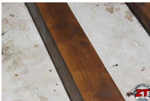
On voit bien la différence avec la finition d'une des pannes entre la lasure d'imprégnation matte et celle de finition en plus brillant.
