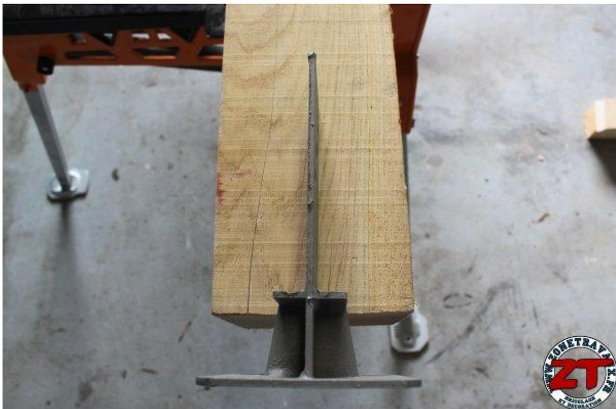
L'encoche est toujours réalisée à l'aide de la scie à onglet et le centre que je n'ai pu atteindre a été finalisé avec un couteau à bois fin.
