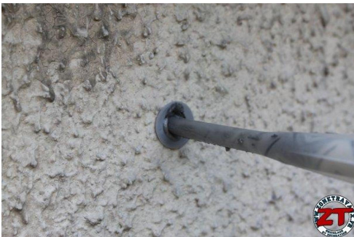
Enfin, pour mettre en place la tige filetée, il faut la visser dans la douille jusqu'au fond, cela permet de bien assurer le contact avec la résine tout au long du pas de vis. Une fois vissée jusqu'à la butée de la douille, assurez vous que votre tige filetée est parfaitement positionnée à la perpendiculaire du mur ! Si ce n'est pas le cas, il sera nettement plus compliqué d'installer votre bastaing dans les 6 trous en même temps.
