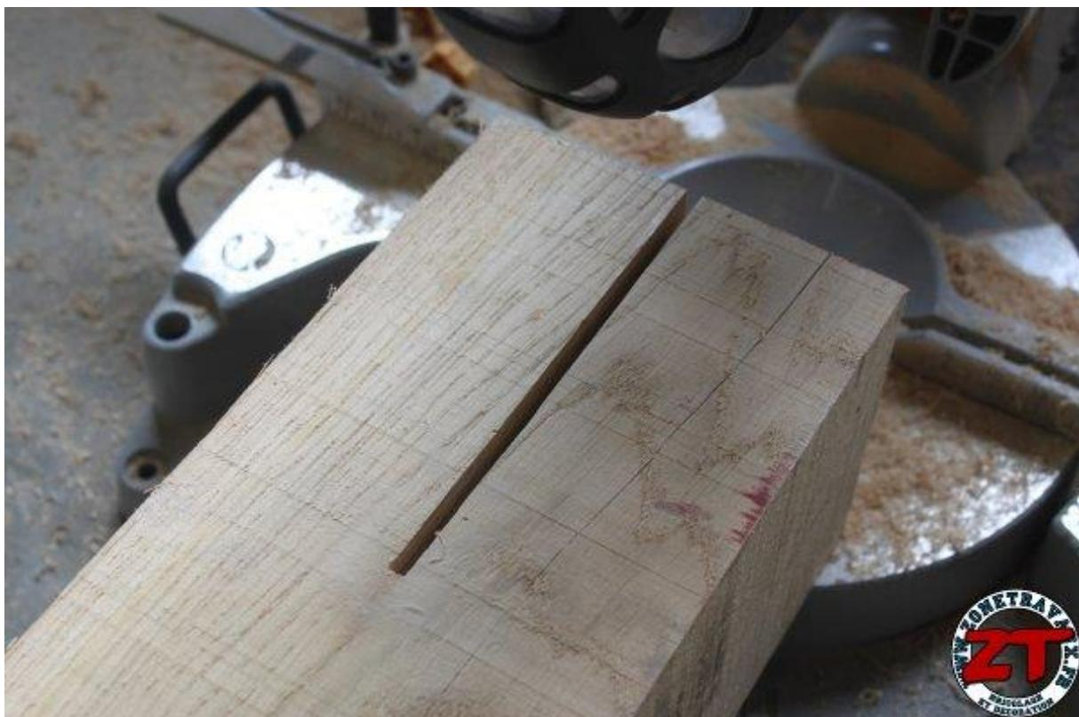
Pour avoir une super finition, j'ai détourné l'épaisseur du pied de platine à l'aide d'un ciseau à bois et de ce fait, le pied de poteau vient s'intégrer parfaitement dans le poteau (tant qu'à tout faire soi-même, faisons le bien !). Enfin, je perce le poteau de bout en bout au niveau des trous de la platine (2 trous) qui permettront de mettre les boulons (2 par poteau).
