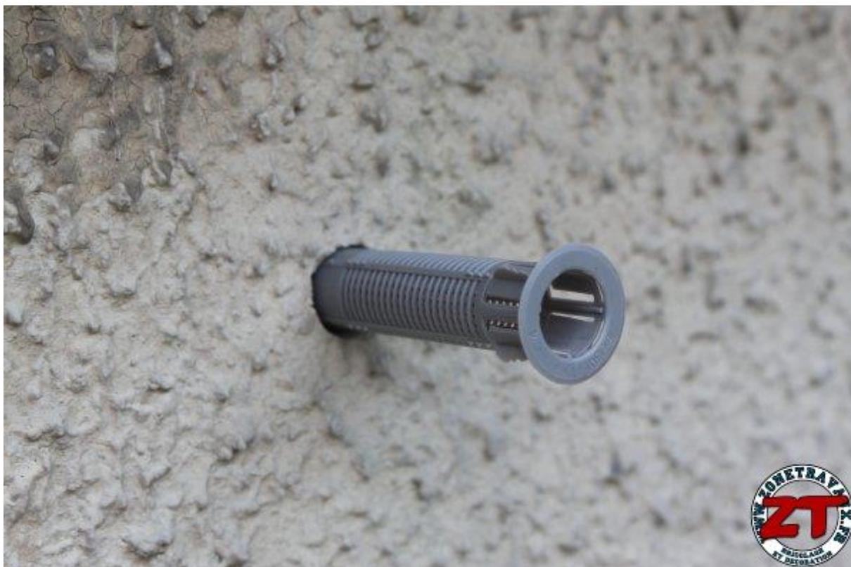
Insérez ensuite le bec dans la douille puis pressez le pistolet afin d'ajouter de la résine. Ne soyez pas radin, il y a largement assez de produit pour réaliser vos 6 scellements chimique donc remplissez entièrement les douilles de produit !
