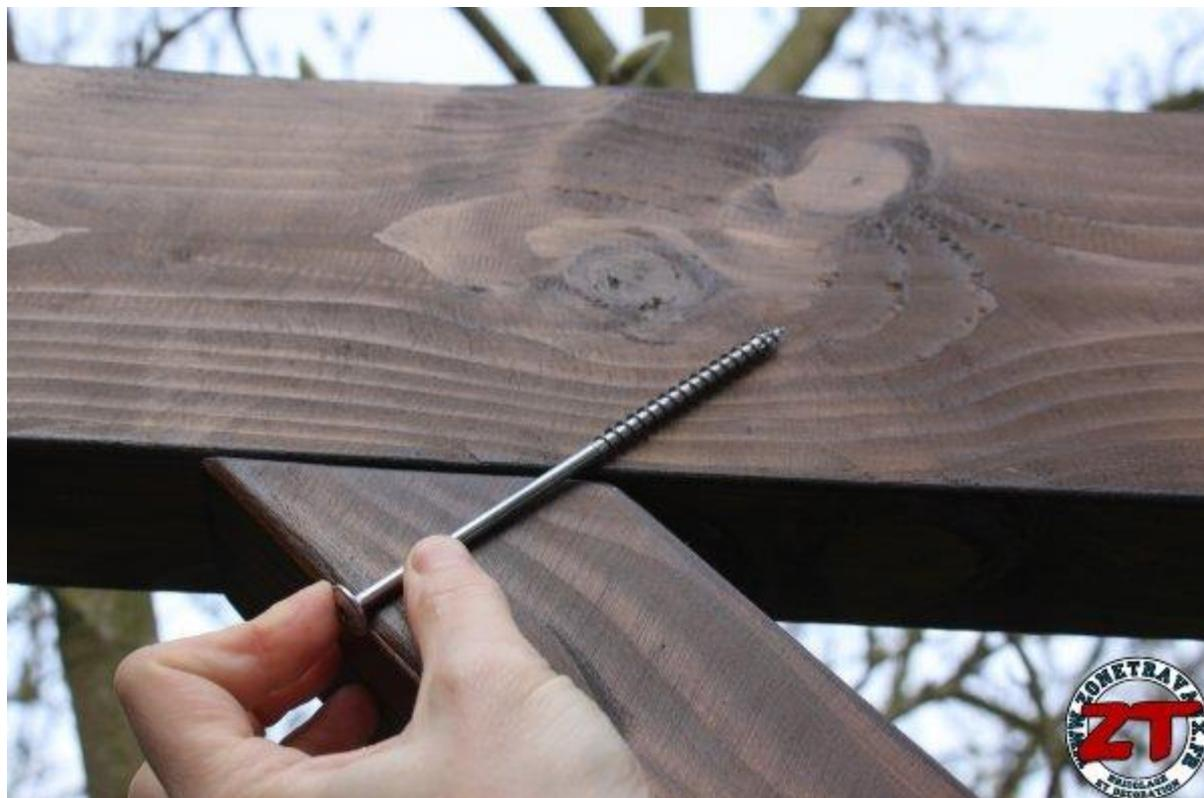
Pour être sûr de mes mesures, je vais pré-visser les vis sur le renfort dans mon atelier et viendrais, ensuite seulement, finir le vissage en place.
